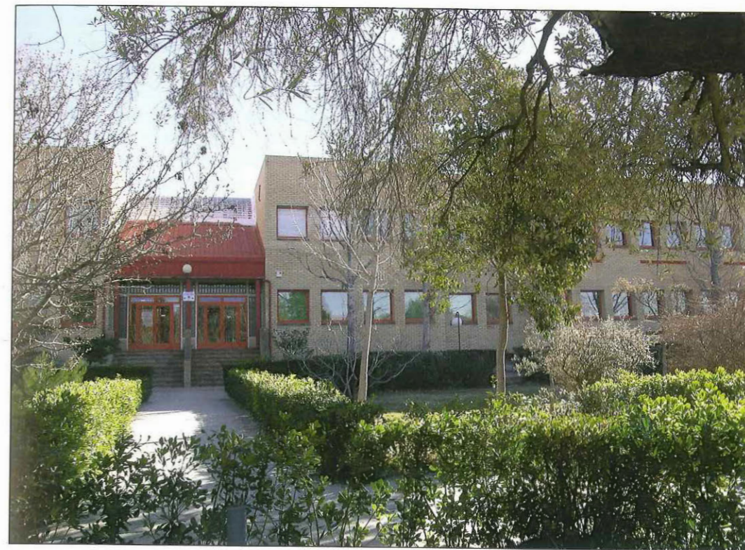
Vista parcial del edificio pluridisciplinar del CITA, sede del Banco de Germoplasma de Zaragoza.
