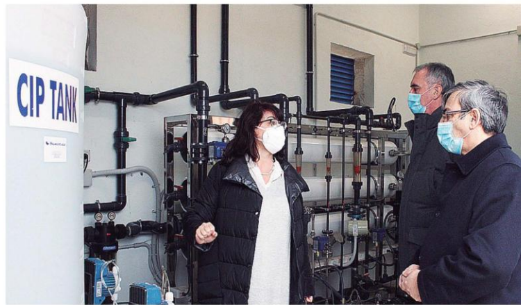
La directora de la obra, explicando el funcionamiento a las autoridades.
