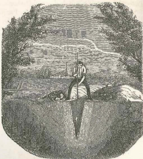
Grav. 21. — Pose des tuyaux de drainage.
