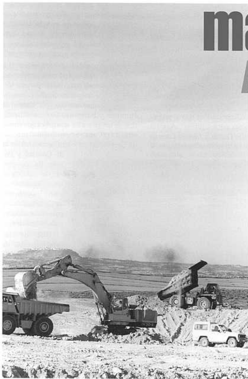
Excavación de la nueva balsa de la C. R. "La Campaña"
