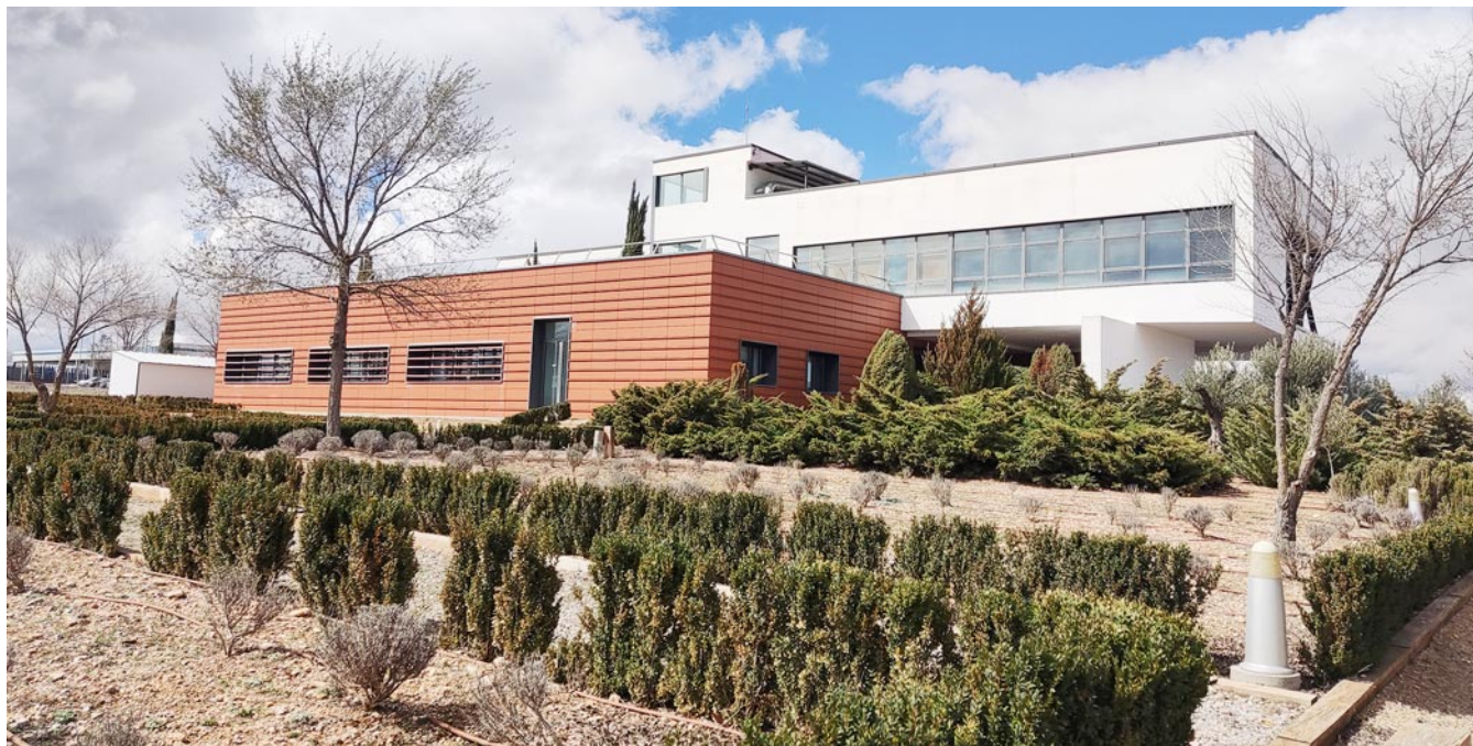
Exterior del CITAté, ubicado en la calle Corinto de la plataforma logística de Teruel (Platea)
