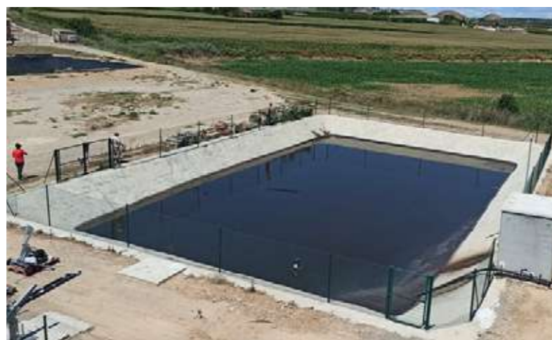
Imagen 3.6. Balsa de almacenamiento de la fracción líquida.
