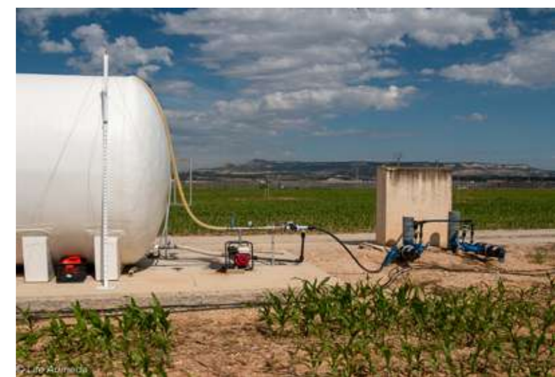
Imagen 4.9. Equipos e instrumentación para el control de los volúmenes de agua y fracción líquida de purín inyectados en la red de riego por goteo de una parcela demostrativa en las Cinco Villas (Aragón, España).
