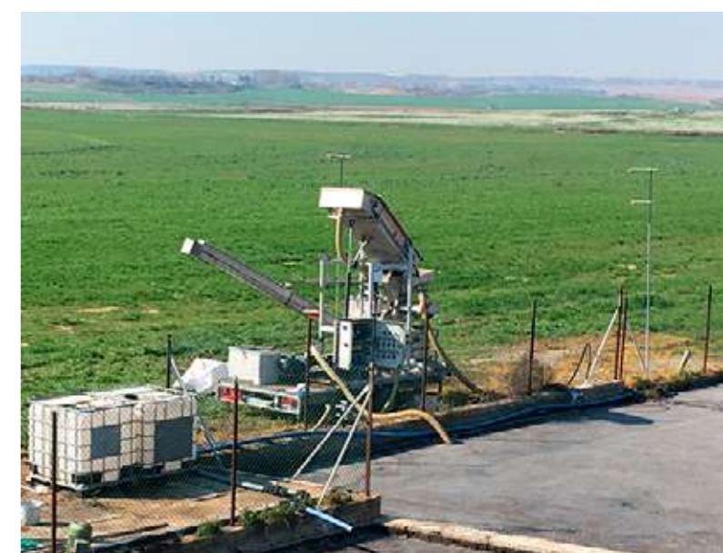
Imagen 5.2. Separador sólido/líquido y balsas de almacenamiento de fracción líquida separada en la granja de porcino de cebo (ES-S2-F3) desde donde se suministró el purín para los ensayos demostrativos en la finca de La Melusa, en La Litera (ES-S2-P, ES-S2-G).
