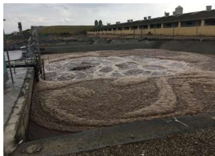
Imagen 3.4. Agitador funcionando en una balsa de almacenamiento.
