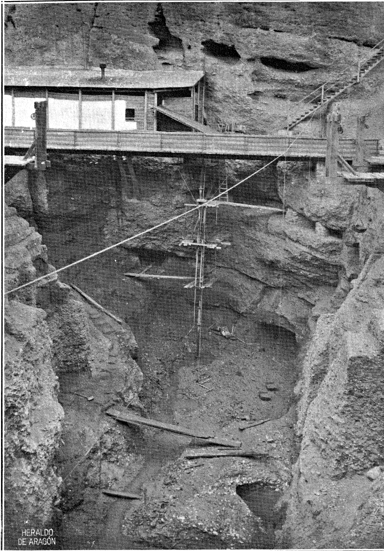
Embalse del río Aguas Vivas, en Moneva y Azuara (Teruel), de 11 millones de mts. cúbs., para riego supletorio de 4.500 hectas. de Samper del Salz, Almonacid de la Cuba, Belchite, Codo, Vinaceite, Almochuel, Azaila e Híjar.—Vista de las excavaciones de 14 mts. de profundidad para cimentar la presa.—Ing., V. García Marién.
