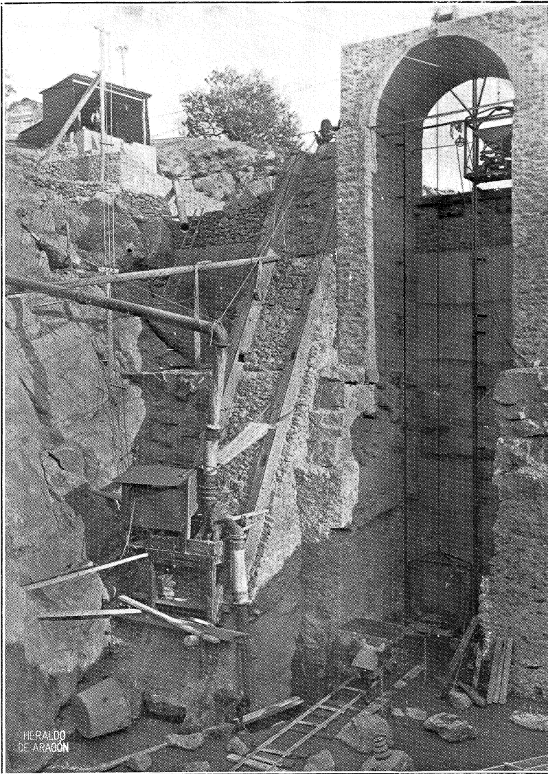
Tren de agotar, de 50 HP, y ascensores para sacar escombros y bajar materiales.
