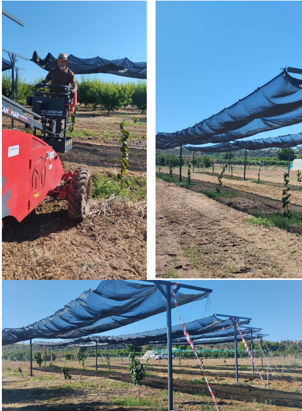
FV 2.3.3. Instalación de malla de sombreo en la plantación de pawpaw de Badajoz
