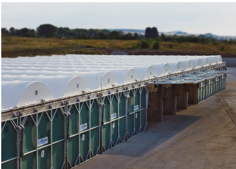
Figura 17. Sistema de túneles de compostaje. Fuente: www.compost-systems.com (2025).
