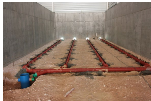
Figura 16. Sistemas de pilas aireadas. (a, b) sistema de pilas con aireación pasiva; (c, d) sistema de pilas con aireación forzada. Fuente: Rynk et al. (1992).
