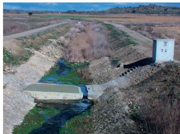
Figura 2. Fotos de las estaciones de aforo construidas por la brigada de la Comunidad General de Riegos de Alto Aragón en los puntos de control P9, P5 y P11.
