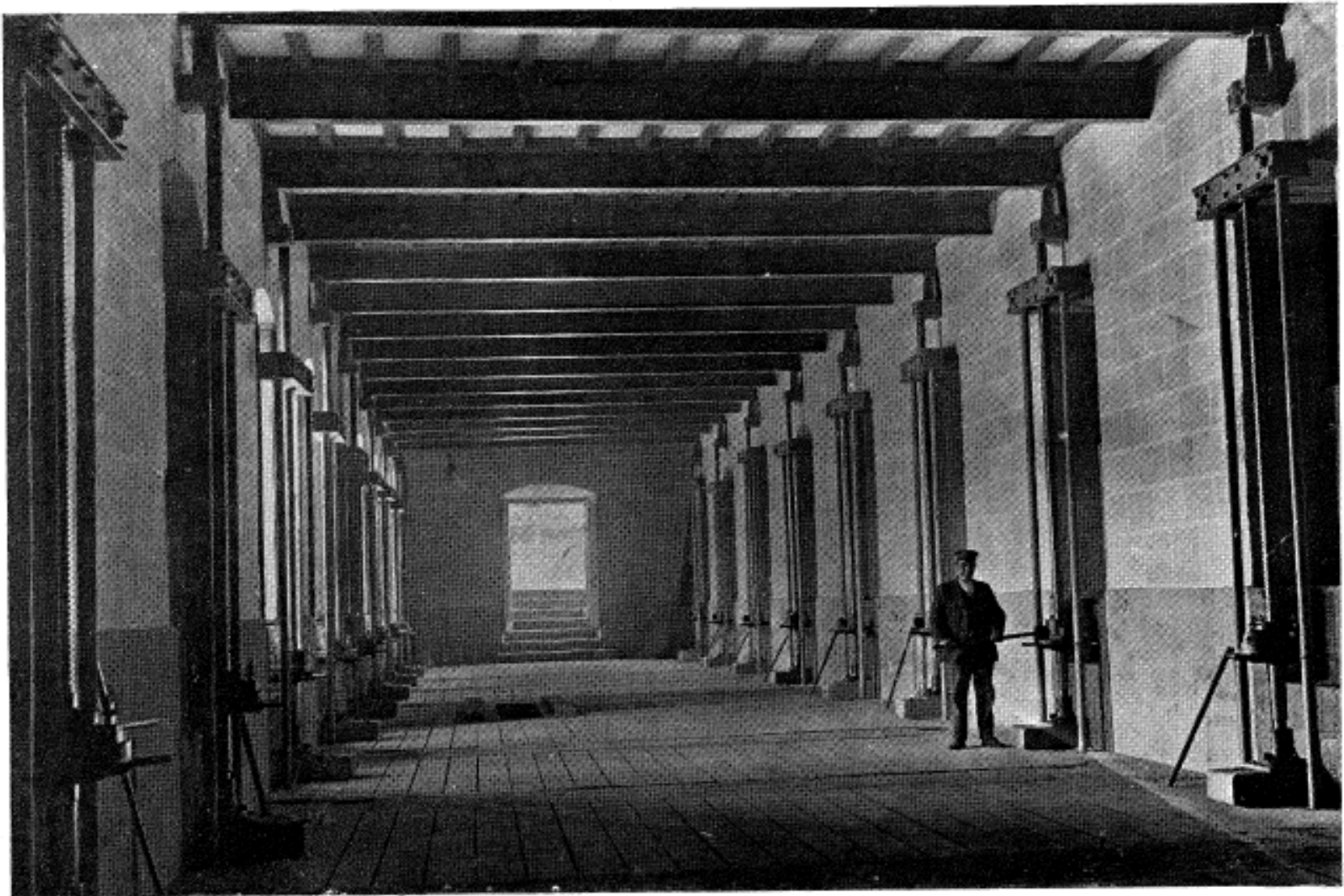
Sala de mecanismos del Bocal, para dobles compuertas de palastro, en 10 vanos de 1,95 mts. de luz y 2,60 metros de altura.
