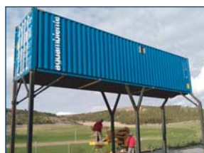
EDAR 200 m 3 /h
