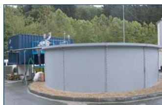
Tto. Biológico. Depósito 150m 3 en PRFV
