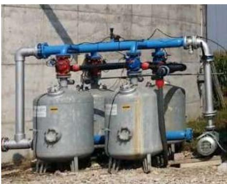
La fracción líquida, después de la microfiltración, pasa a través de una serie de filtros de arena de cuarzo con tres granulometrías diferentes.
