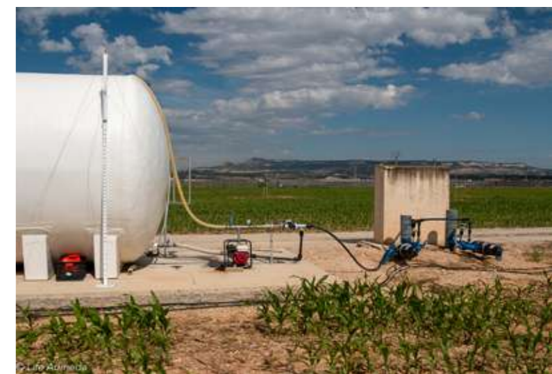
Foto 4.9. Strumentazione per il controllo del volume iniettato nel corso della fertirrigazione in un impianto a goccia presso Cinco Villas.
