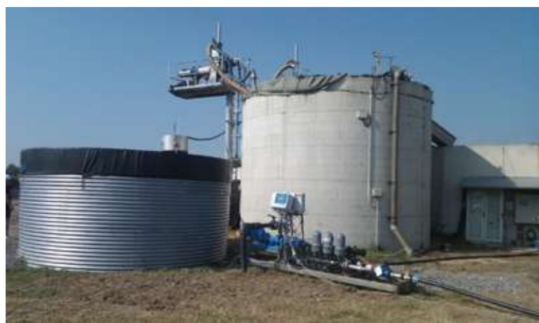
Foto 3.7. Iniezione diretta della frazione liquida di digestato dal serbatoio dell'azienda nel sistema di irrigazione.
