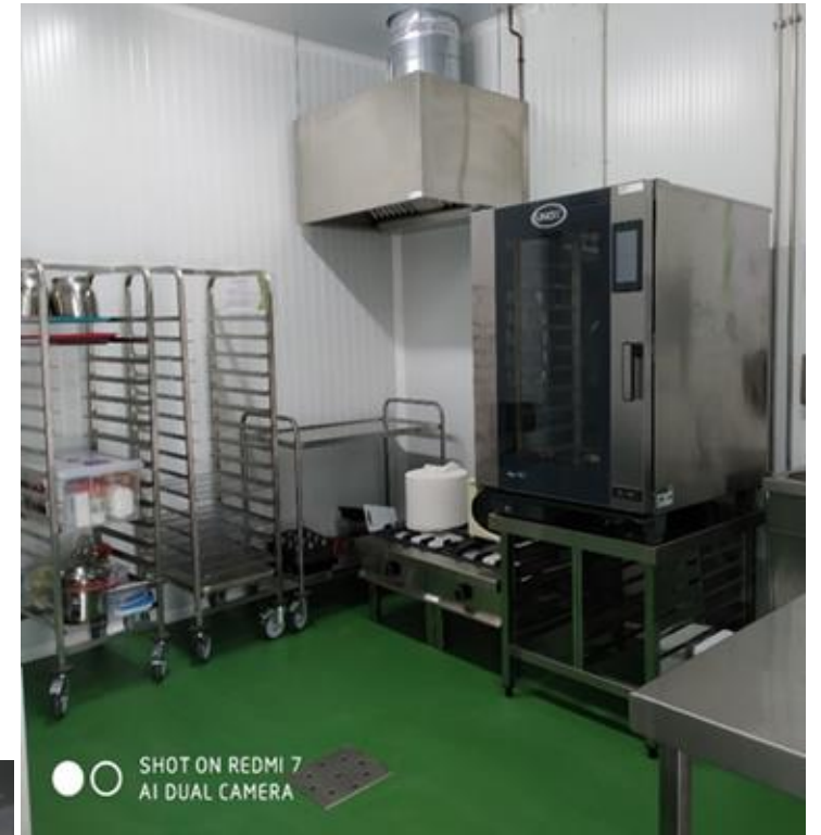
Obrador de Repostería y Mermeladas
