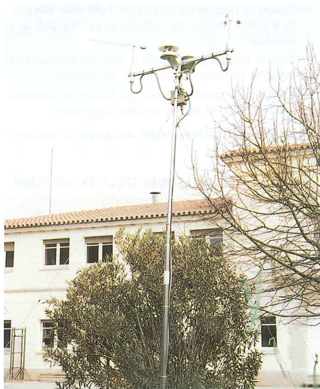
Estación automática. Sensores.
