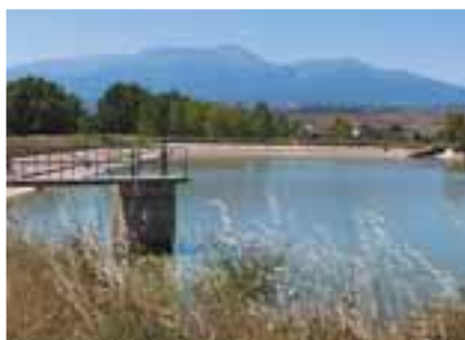
Figura 6: Embalse de Santa Ana que regula la Acequia Magallón Grande de la Comunidad de Regantes de Tarazona.
