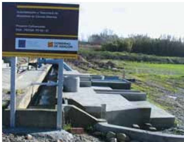
Figura 8: Acequia de pruebas de medida de caudal en la finca experimental del CITA de Aragón en Montañana, Zaragoza.
